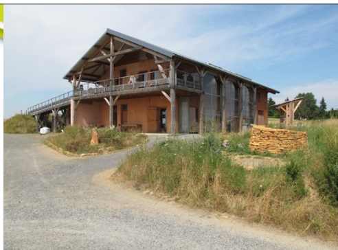
Ecocentre du Lyonnais, La Tour de Salvagny
