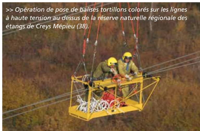
>> Opération de pose de balises tortillons colorés sur les lignes à haute tension au dessus de la réserve naturelle régionale des étangs de Creys Mépieu (38).
