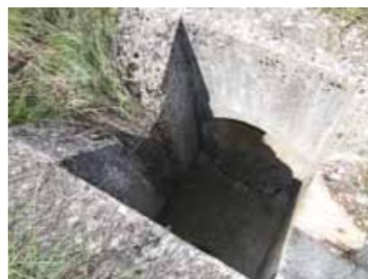
>> Fosse d'écoulement des eaux pluviales sous voirie dont une paroi pourrait être aménagée en pente douce.
